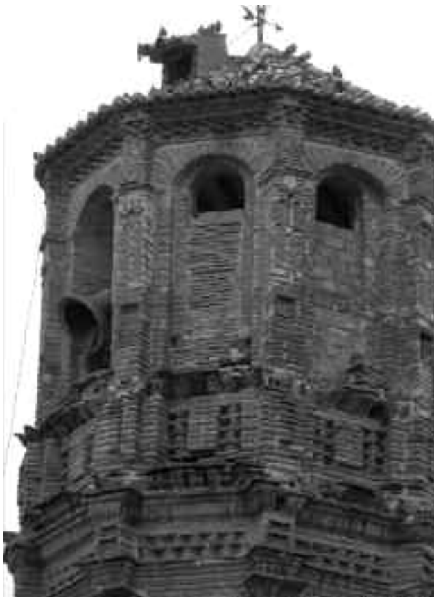
Detalle de la torre.
